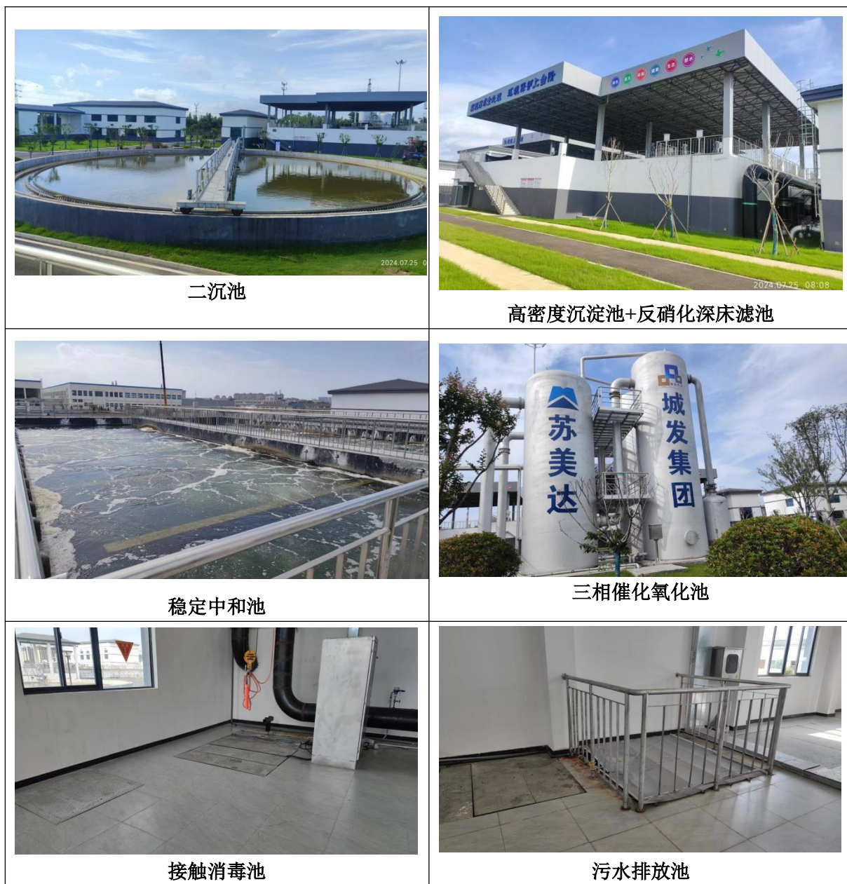
图 4.1-2 污水处理设施照片
