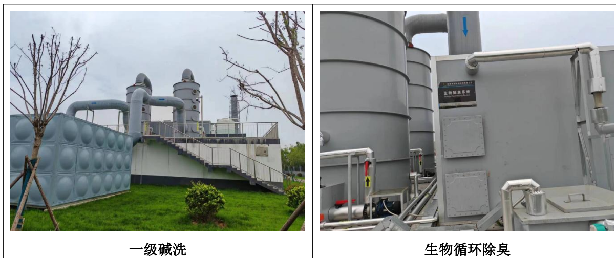
图 4.1-4 废气治理设置照片
